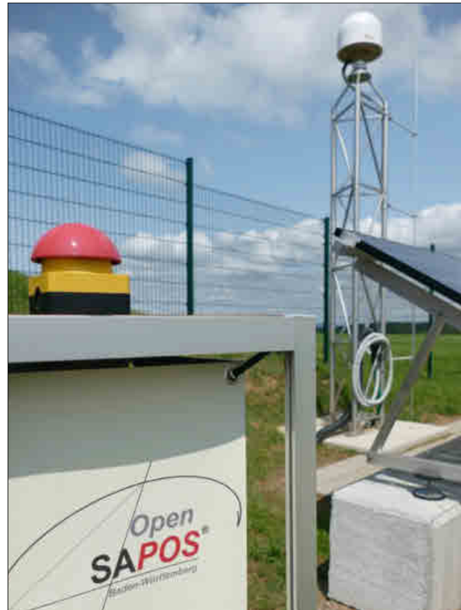
Startschuss für die Sapos-Station in Göschweiler
